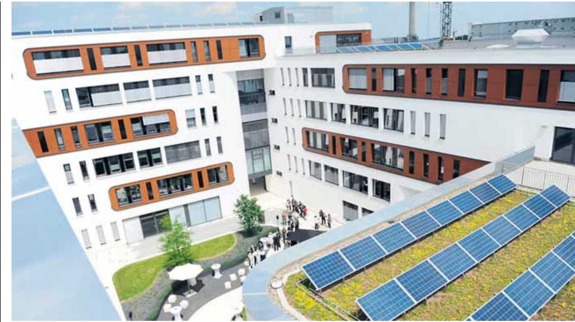
Futuristisch in weiß und braun: Das NuOffice macht Ernst mit der Nachhaltigkeit. Auf den Dächern blühen Solarzellen und heimische Pflanzen.
